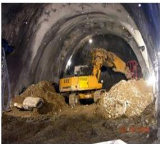
6-сурет. Liebherr R932 экскаваторы және «Meuco Suprima» машинасы
