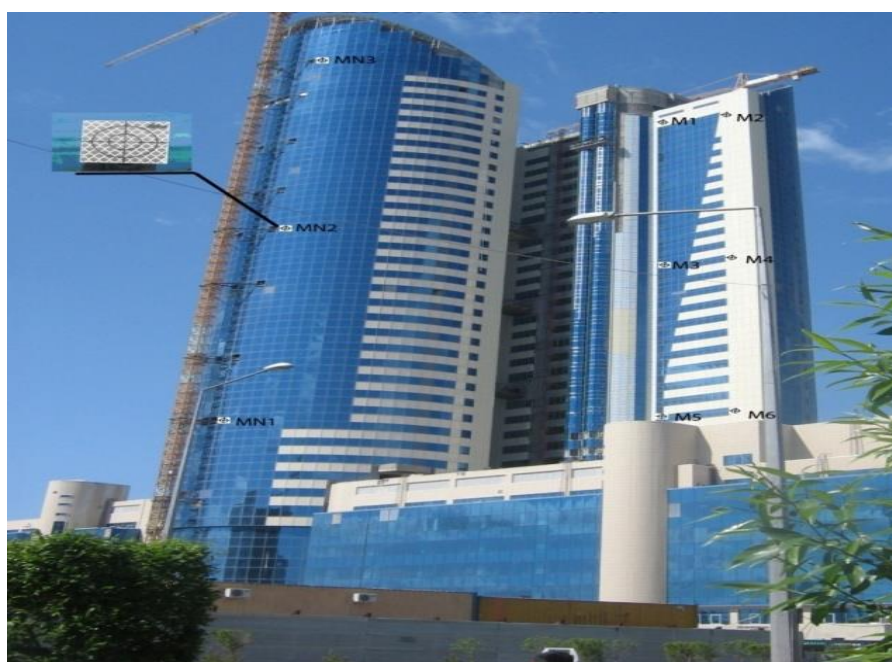
19-сурет. Гимараттағы бақылау маркаларының орналасуы
